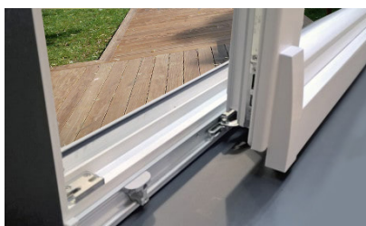
Roulements adaptés au poids du vitrage
