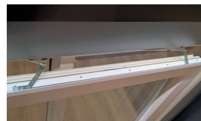
Double compas pour une sécurité maximale
